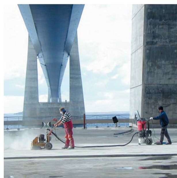
Forbehandlingen af betonen blev foretaget med slyngenser.
