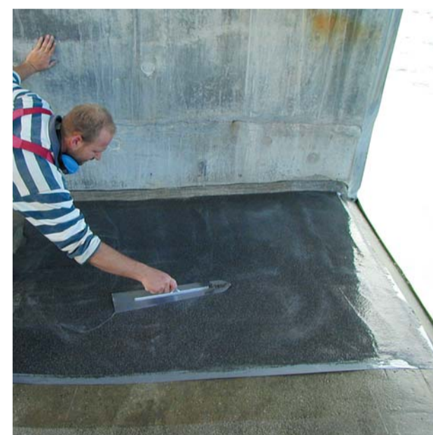
Acrydur® Bridge udlagt med glittebræt. Det er også muligt at udlægge stående.
